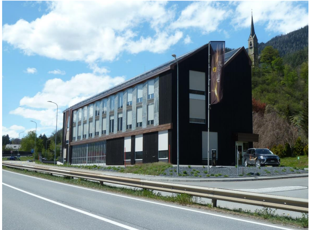
Abbildung 56: Markanter Neubau Rhienergie am unteren östlichen Dorfeingang
