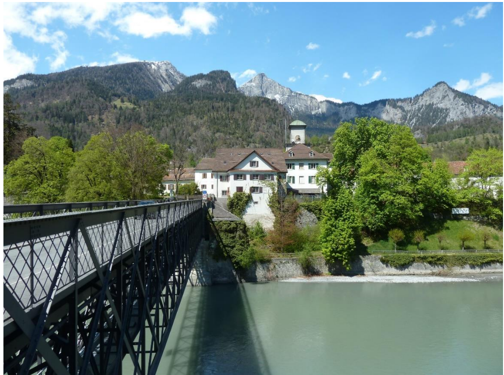
Abbildung 19: Rheinbrücke bei Reichenau
