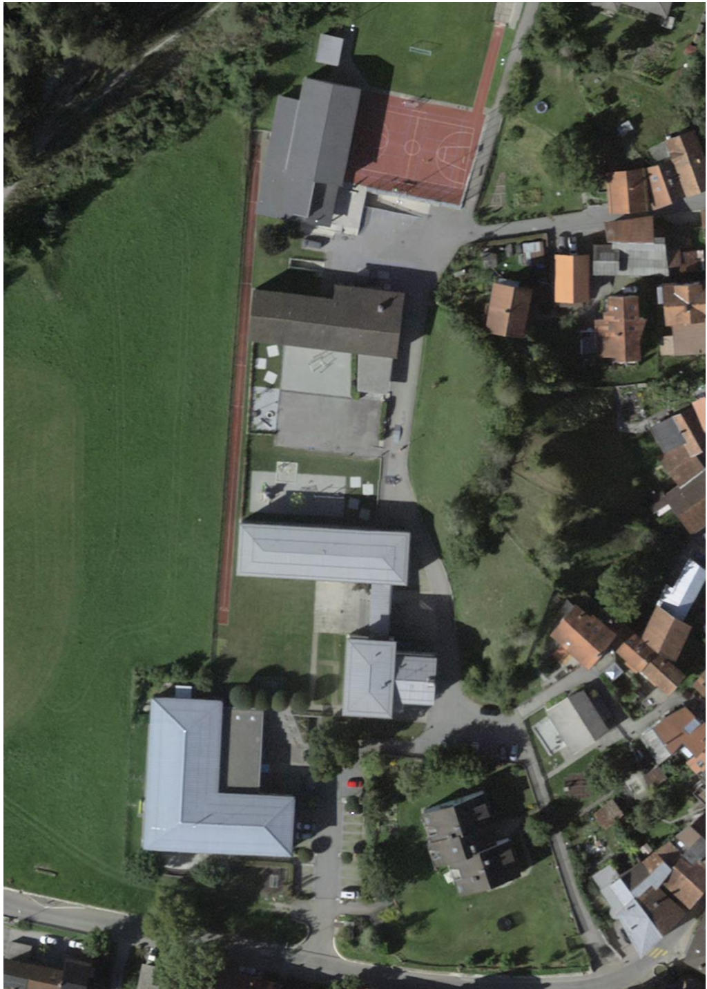
Abbildung 27: Schulkomplex (Quelle: GeoGR, Zugriff April 2021)
