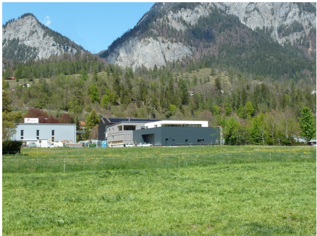
Abbildung 55: Grossvolumige Baukörper im Gewerbegebiet
