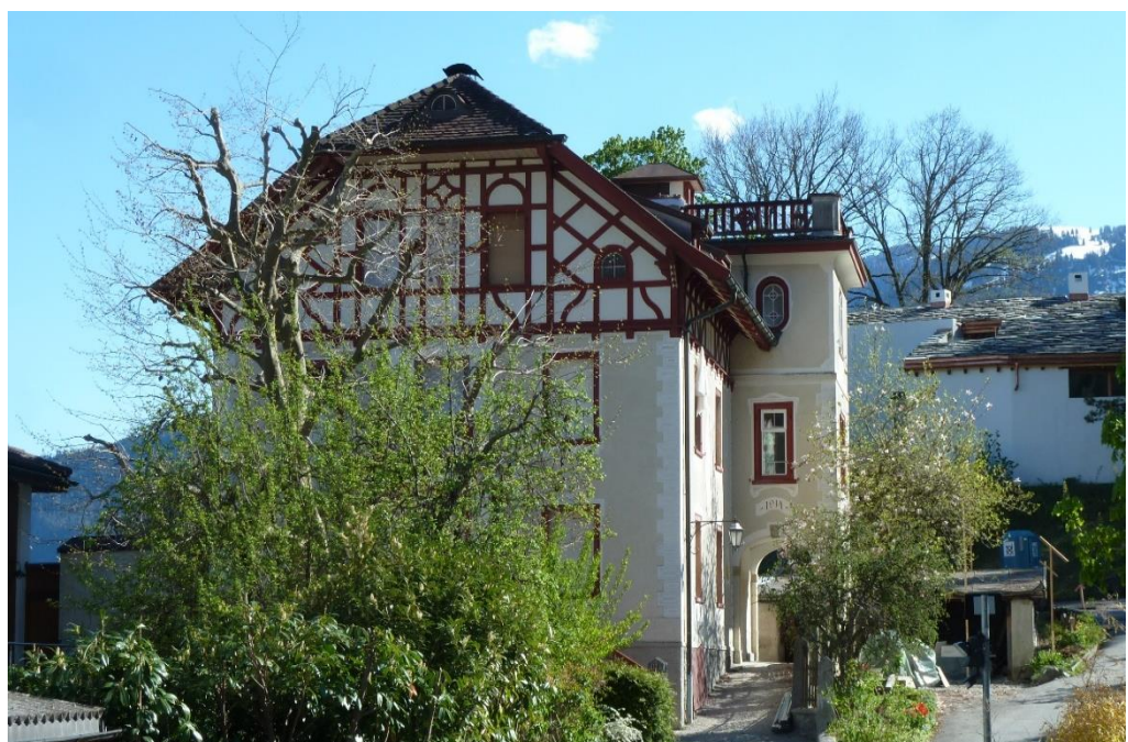
Abbildung 49: Stattliches Wohnhaus im Heimatstil
