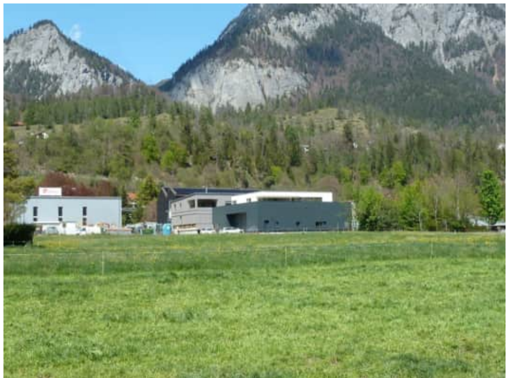
Abbildung 55: Grossvolumige Baukörper im Gewerbegebiet
